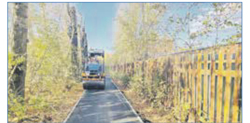
Обустройство дорожки к улице Пархоменко
