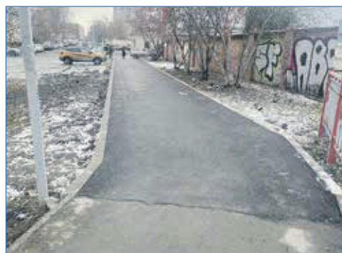
Тротуар на переходе к улице Семьи Шамшиных подняли. Больше его не будет затапливать
