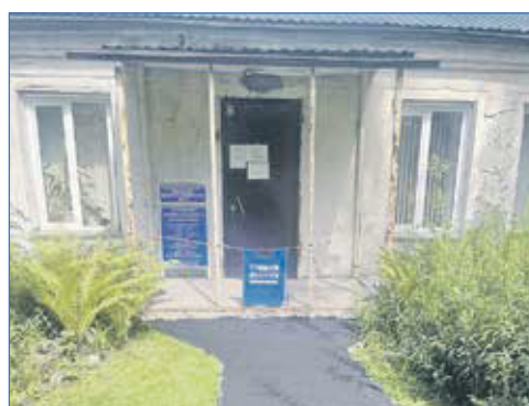
На дорожку, ведущую к ДШИ-17, уложили новый асфальт
