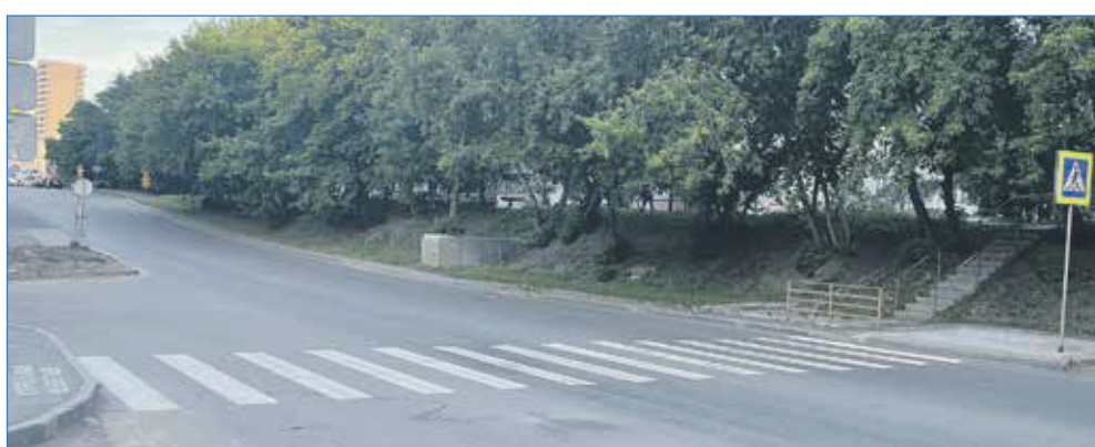
Так выглядит пешеходный переход на ул. Кропоткина, 267
