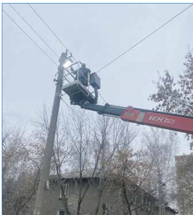
Ремонт освещения на ул. Добролюбова
