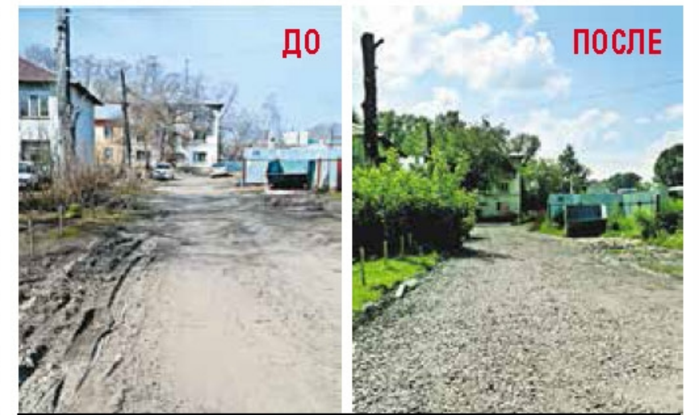
Ремонт дороги по ул. Колхидской, 21
