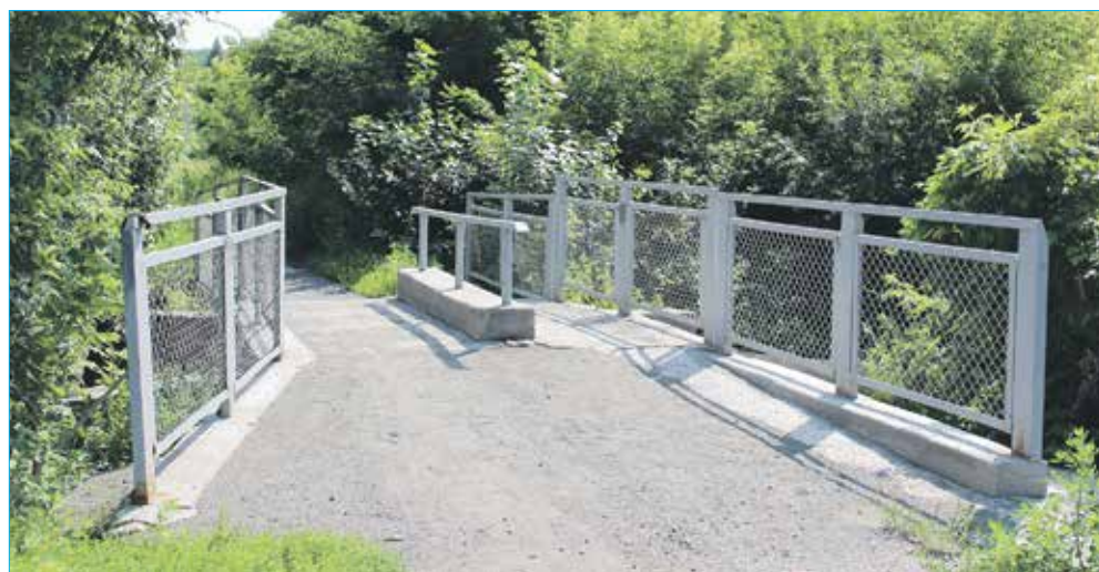
Ремонт моста через реку Каменка
