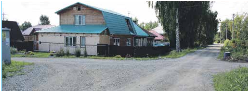
Ремонт дорог частного сектора по наказам избирателей, 4-я Рабочая улица
