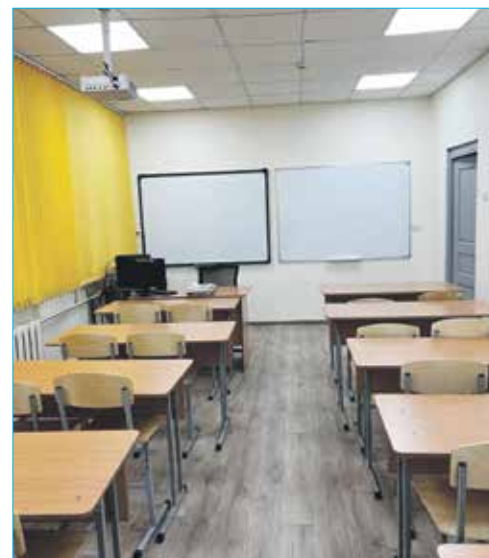
В школе №178 проведен капитальный ремонт пола в нескольких кабинетах
