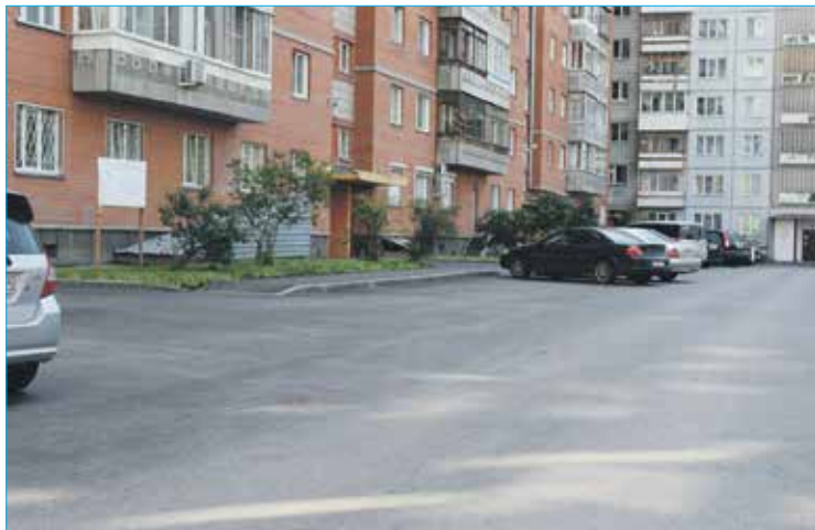
Замена асфальтового покрытия с обустройством пешеходных дорожек и парковочных мест по приказам избирателей во дворе дома Учительская, 8
