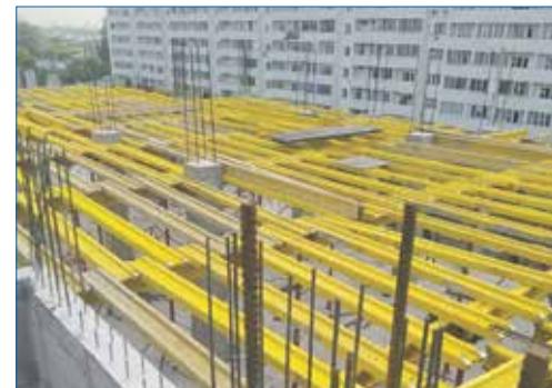
Продолжается строительство 22 поликлиники
