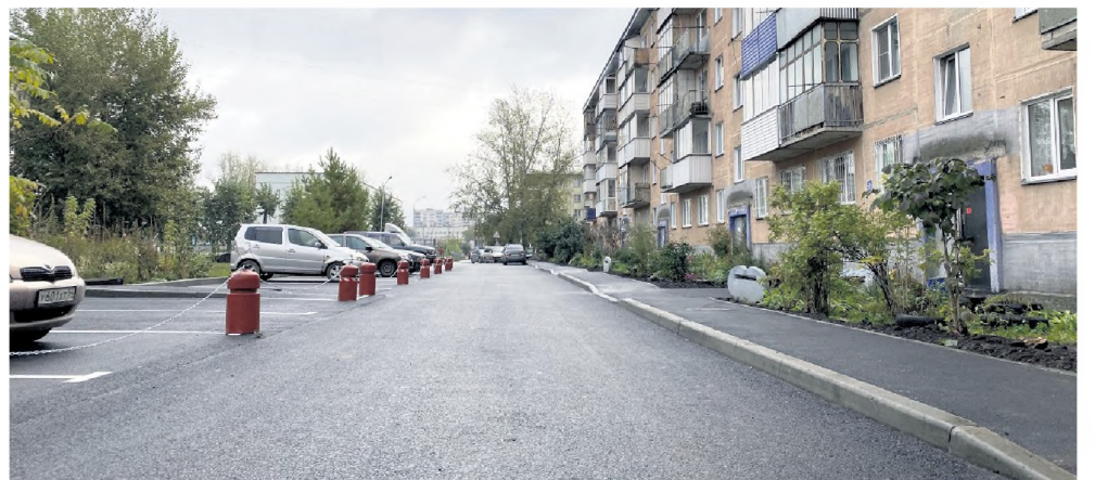
Институт наказов в действии: ремонт на улице Ударная, 19
