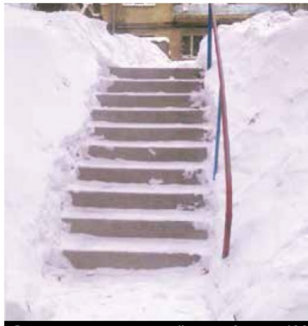
Ремонт лестничного пролёта, ул. Обская, 139
