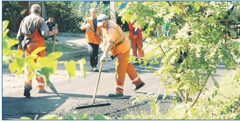
Дороги частного сектора приводят в порядок
