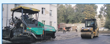
Ремонт двора по ул. Барьерная, 12/40 лет Комсомола, 54
