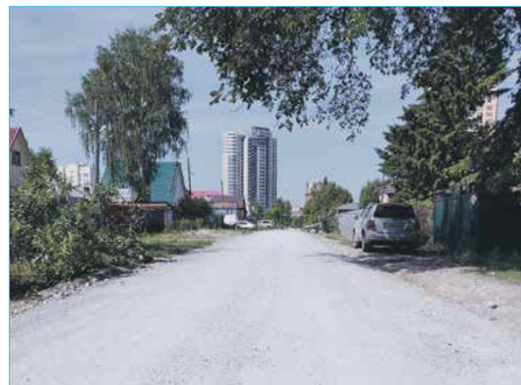
Ремонт дорожного полотна на ул. Кавалерийской
