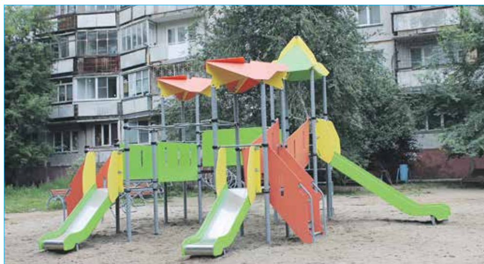
Установка новой детской площадки в рамках проекта «Территория детства» от партии «Единая Россия» по ул. Олеко Дундича, 1
