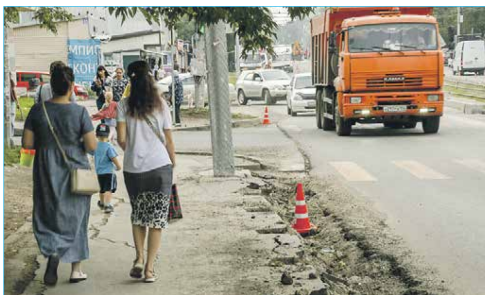
Неудобства ремонта временные, а благоустройство будет постоянным
