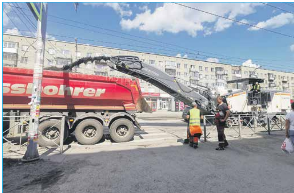
Комплексный ремонт на ул. Учительская идет днем и ночью
