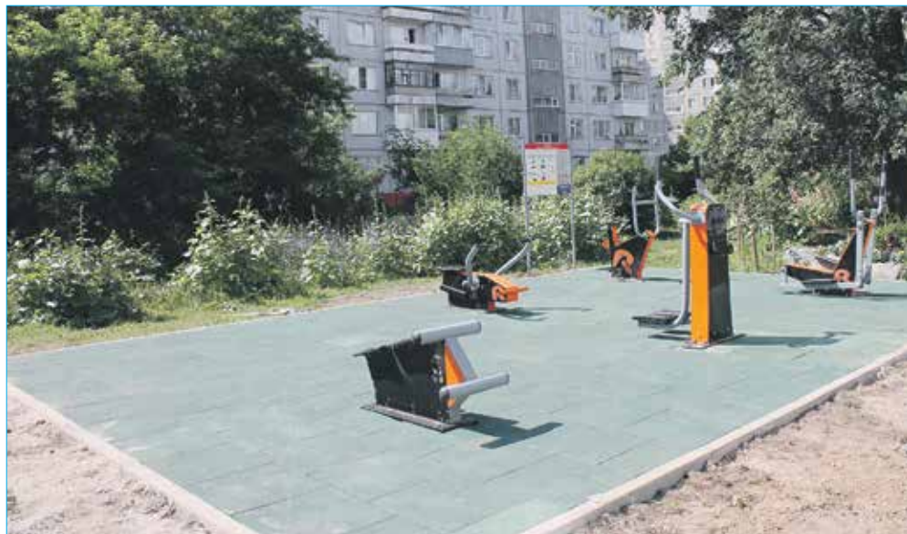
Обустройство покрытия на детской площадке, ул. Кропоткина, 134
