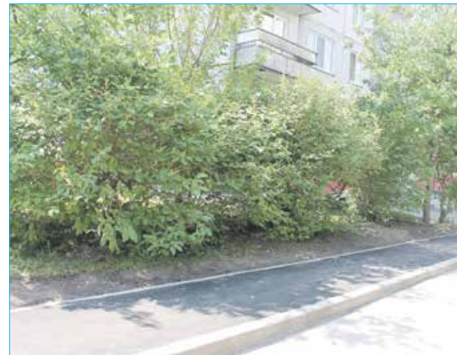
Обустройство тротуара на ул. Кропоткина, 136
