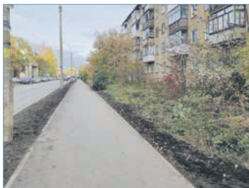
Ремонт тротуара к Аэрокосмическому лицезу
