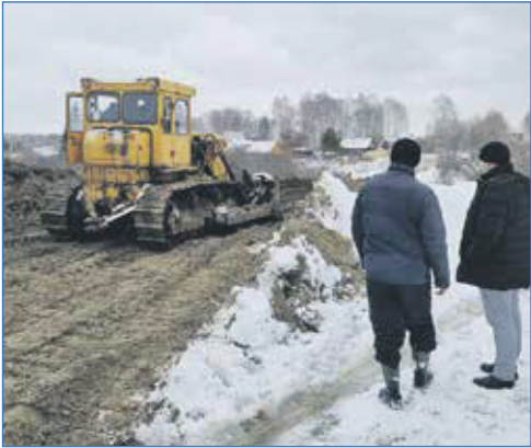
Строительство дороги от 2-го Легкого проезда к части дороги ул. Профилактическая
