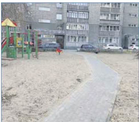
Новая пешеходная дорожка во дворе дома 123 на ул. Жуковского
