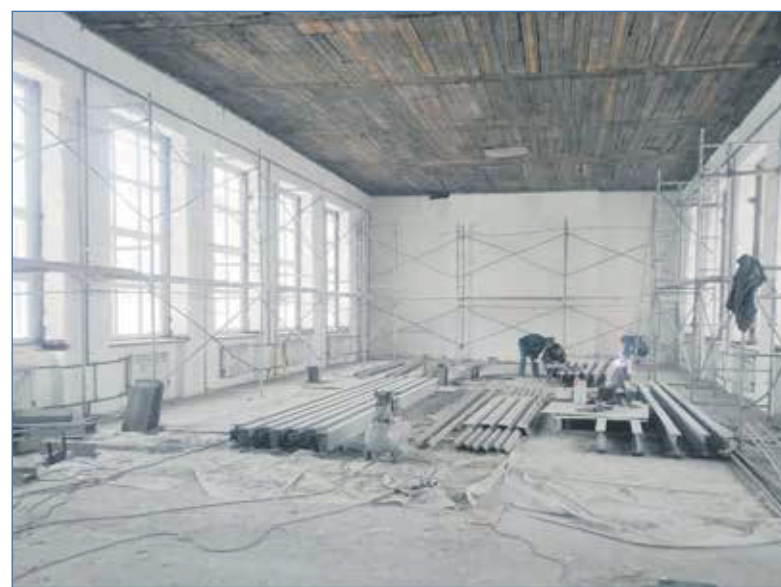
Капитальный ремонт 167-й школы
