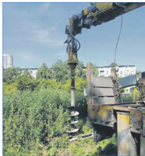
Подготовка территории к установке фонарных столбов
