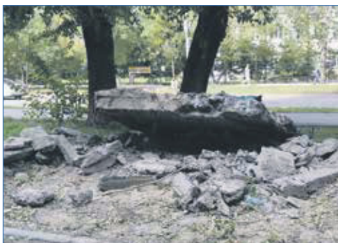
Демонтаж плиты на ул. 1905 года, 30
