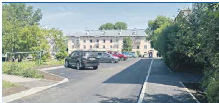
Внутриквартальное асфальтирование территории на ул. Мира, 19, 21 и ул. Бурденко, 14а
