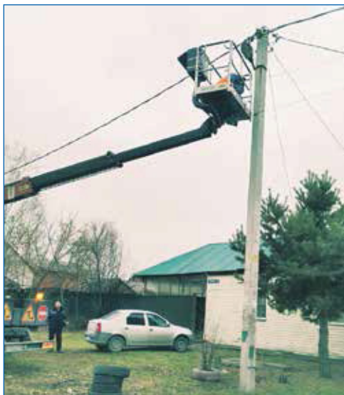
Замена уличного освещения в частном секторе
