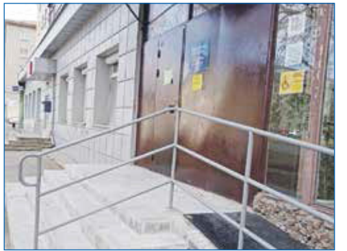
Отремонтированное крыльцо библиотеки
