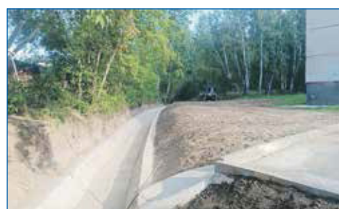
Водоотведение на улице Амосова
