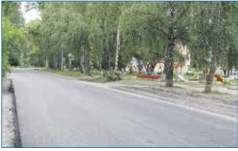
Ремонт дороги на улице Флотской
