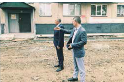
Благоустройство на улице Амосова в процессе
