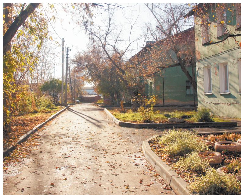
На ул. Катодная проведен ремонт проездов
