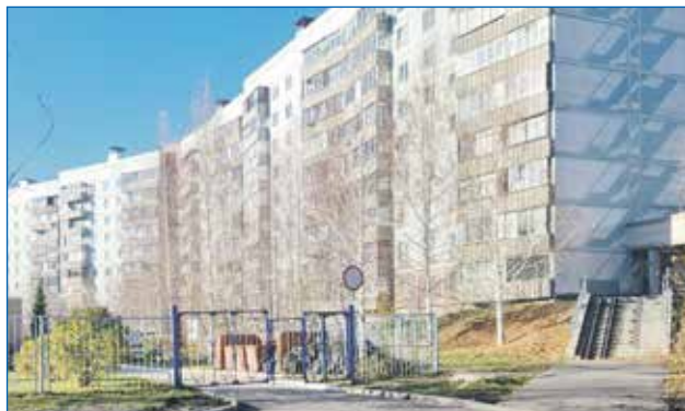
В 2022 году была обустроена лестница к почтовому отделению...
