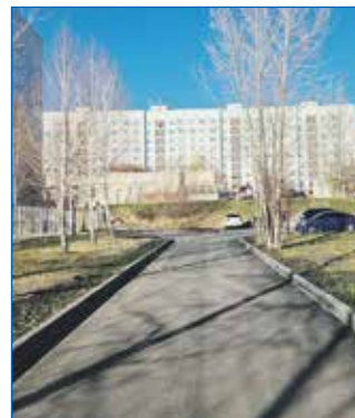
...а в 2023 году отремонтирован подъезд к детскому саду
