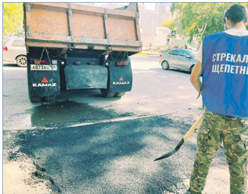
Своими силами подняли уровень асфальта на тротуаре возле Рельсовой, 5, чтобы на нем не застилавалась вода после дождей
