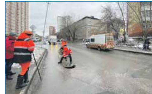
Восстановление ливневой канализации по ул. Дачная, 31
