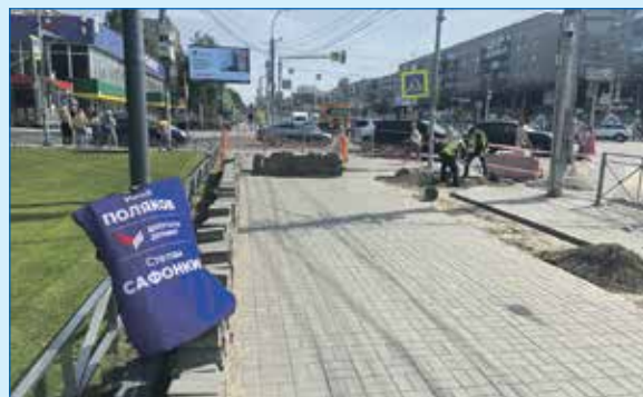
Ремонт ливневой канализации на пересечении Красного проспекта и улицы Кропоткина
