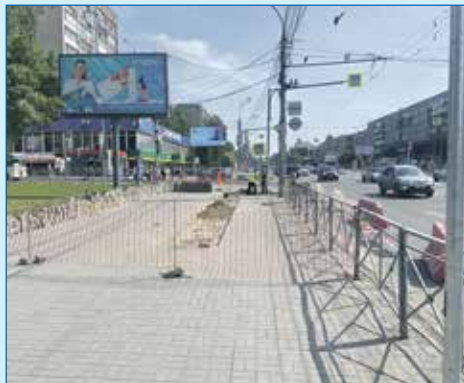
Ремонт ливневой канализации на пересечении Красного проспекта и улицы Кропоткина
