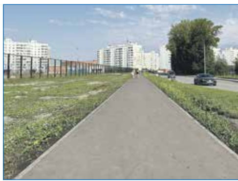
Завершено строительство тротуаров по ул. Танкистов
