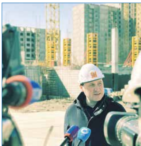
Строительство поликлиники идет полным ходом
