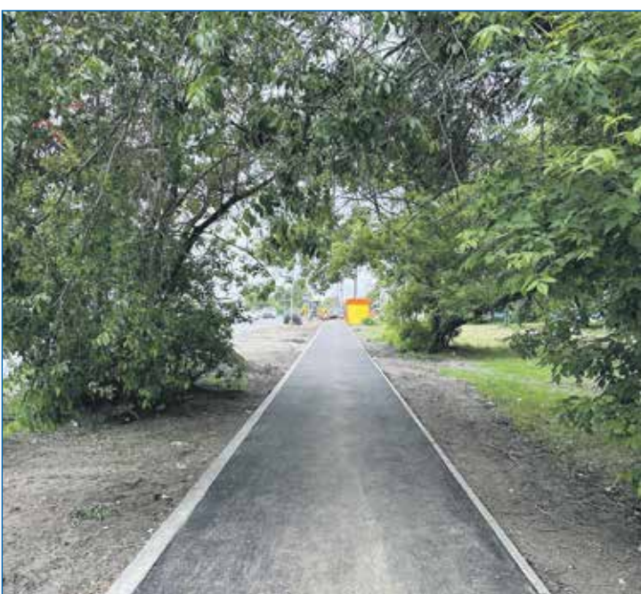
Строительство тротуаров для обеспечения безопасного маршрута в школу на завершающей стадии
