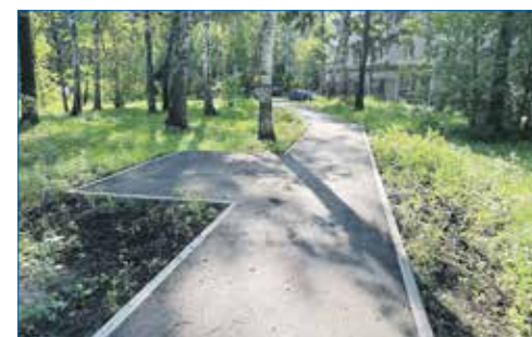
Обустройство тротуара от ул. Иванова, 43, до ул. Иванова, 45
