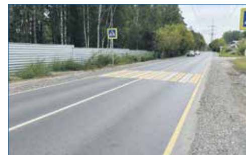
Ремонт ул. Иванова в сторону трассы на Кольцово
