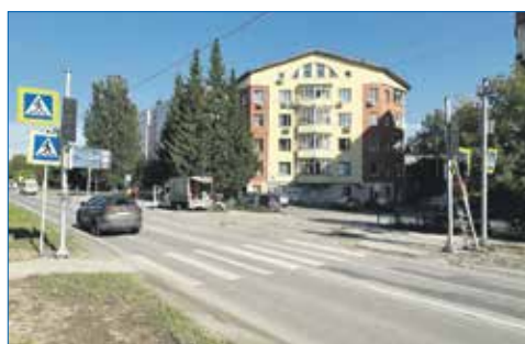
Установка светофора по требованию ул. Арбузова, 10
