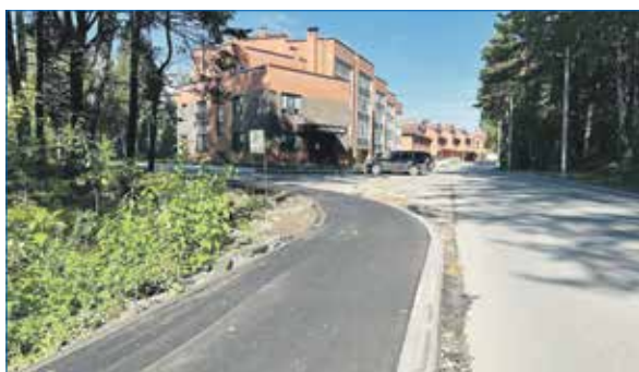
Новый тротуар вдоль Садового проезда
