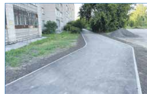
Ремонт тротуарных дорожек за домами ул. Демакова, 17, 17/1
