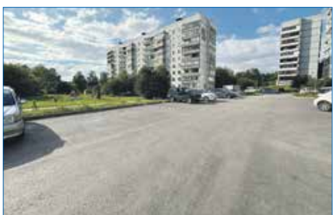
Ремонт проезда и расширение парковки во дворе ул. Экваторная, 14
