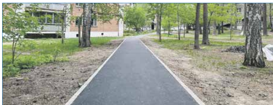
Обустройство тротуара от ул. Иванова, 37, до ул. Иванова, 47
