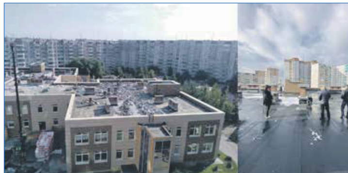
Завершены работы по ремонту кровли детского сада №4 «Семья»
