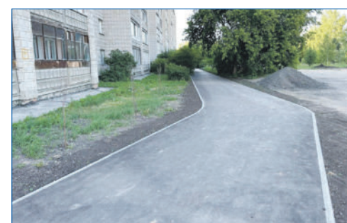
Ремонт тротуарных дорожек за домами ул. Демакова, 17, 17/1
