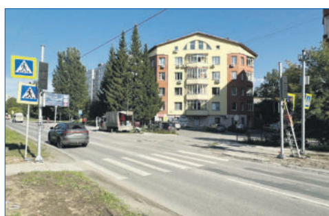
Установка светофора по требованию ул. Арбузова, 10
