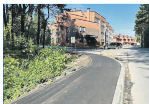
Новый тротуар вдоль Садового проезда
