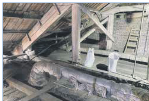
Ремонтные работы по замене утеплителя над 1 этажом ДДК им. М.И. Калинина
