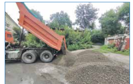
Благоустройство территории (пр. Дзержинского, 2)
