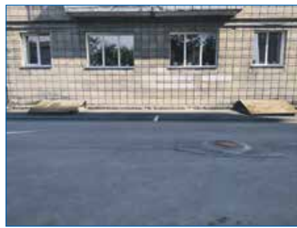
Установлено 15 новых окон в библиотеке им. В.П. Чкалова
