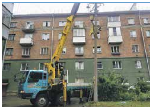
Демонтаж столбов. Улица Давыдова, 26
