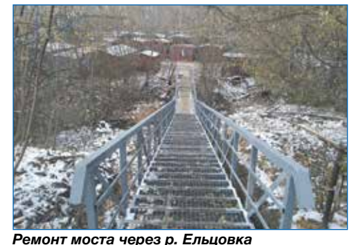
Ремонт моста через р. Ельцовка (ул. Д. Давыдова, 7/1)
