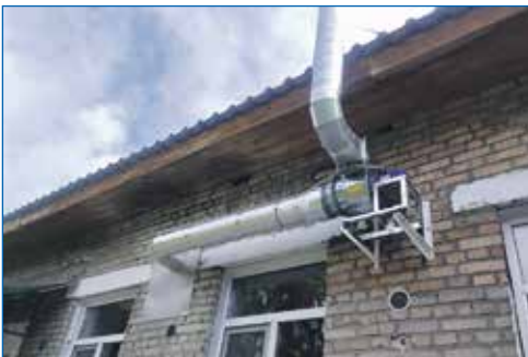
Обустройство приточной вентиляции в детском саду №329
