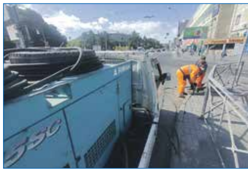
Демонтаж дефектных бордюров на проспекте Дзержинского
