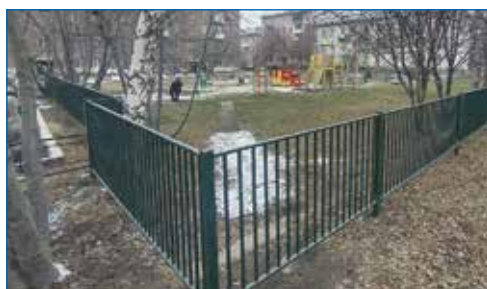
Установка ограждения на придомовой территории, ул. Промышленная, 1а
