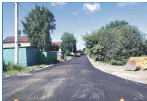
Ремонт в асфальте ул. Писарева
