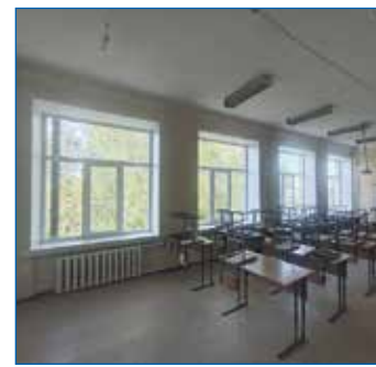
Замена окон в школе №111
