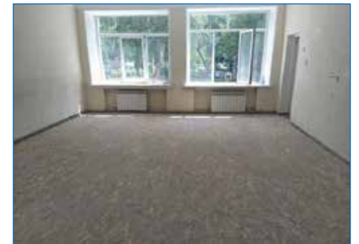
Ремонт пола в группе детского сада № 163
