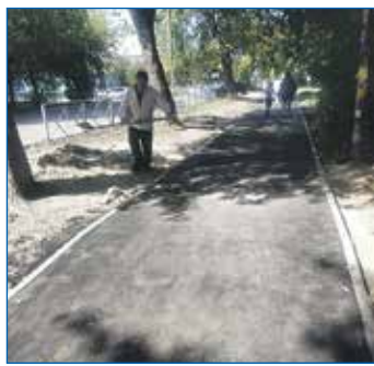
Ремонт тротуара, ул. Королёва, 27
