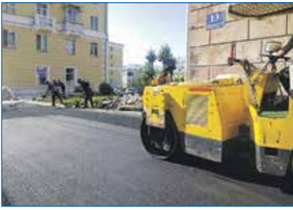
Ремонт тротуара вдоль дома по ул. Авиастроителей, 13
