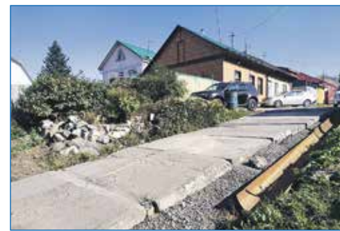
Ремонт асфальтовой крошкой ул. Черноморская
