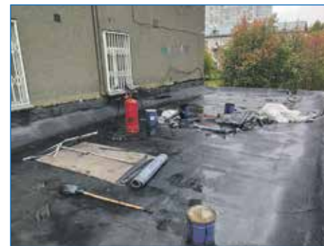
Ремонт мягкой кровли ДК «Точмашевец»
