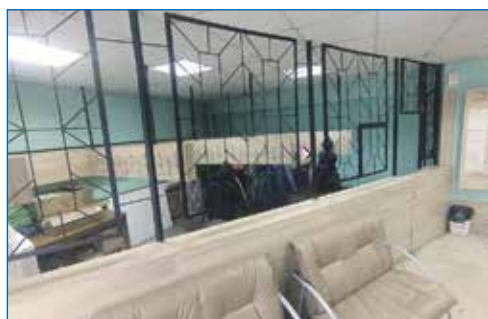
Ремонт гардероба в ДК «Точмашевец»
