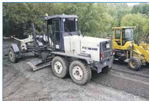
Ремонт дороги в СНТ «Золотая горка»
