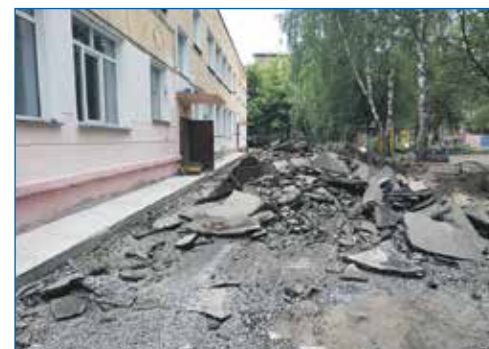
Замена асфальта в детском саду № 163
