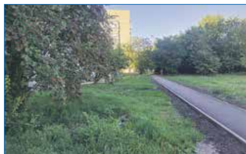
Асфальтирование тротуара от дома Лазарева, 31, до проходной №2 завода им. Чкалова
