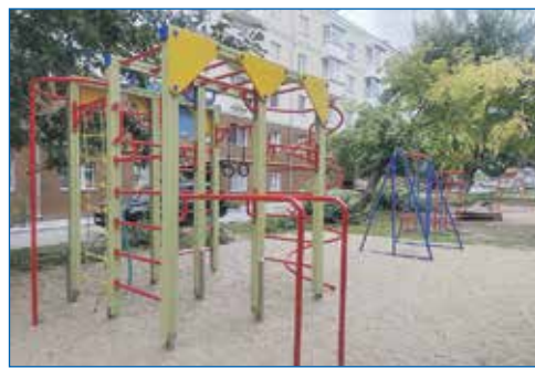
Установка детской площадки с мягким покрытием, ул. Д. Давыдова №№2 и 2а
