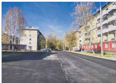
Ремонт улицы Театральная
