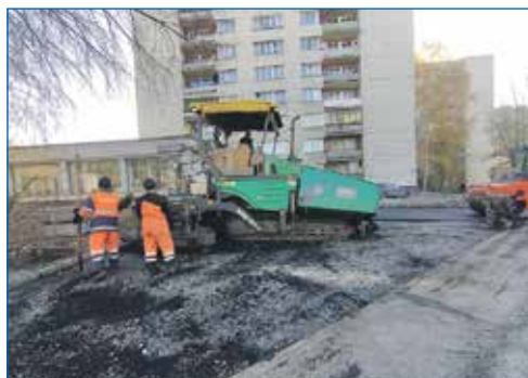
Улица Лазарева, 31а: ремонт двора
