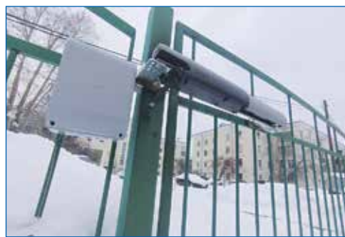
Установка автоматических доводчиков на ворота, детский сад №262
