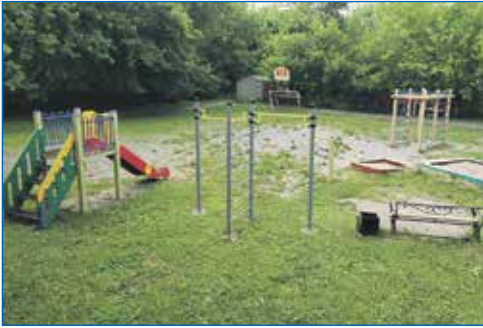
Установка спортивных элементов, ул. Новая Заря, 11
