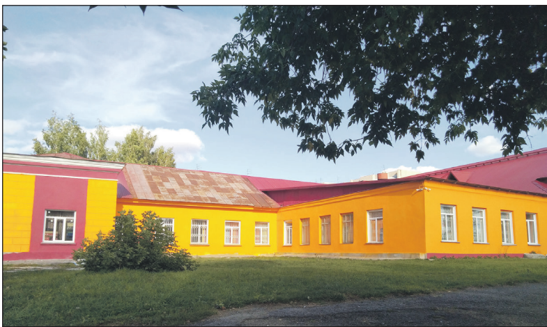
Ремонт фасада ДДК имени Калинина — это наша общая задача
