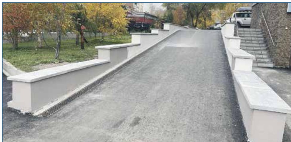
Подпорная стенка дома Красный проспект, 100, после реконструкции
