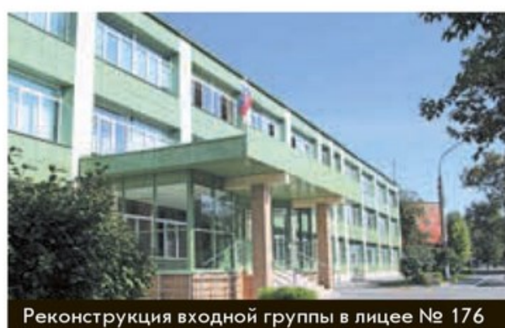
Реконструкция входной группы в лицее № 176
