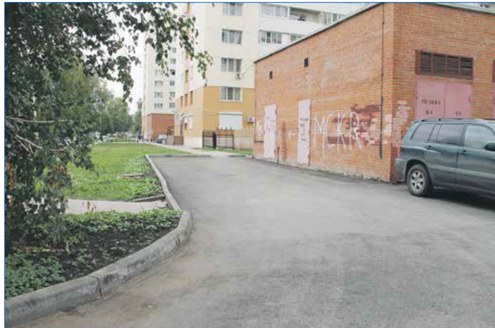
Асфальтирование, ул. Зорге, 298
