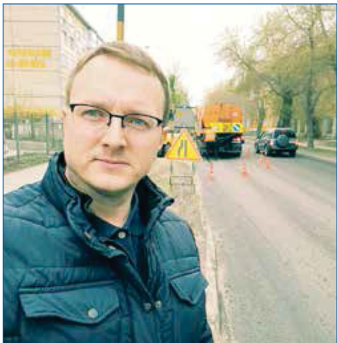
Ремонт на ул. Народной
