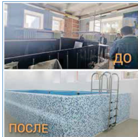
Обновлённая чаша бассейна коррекционной школы № 31
