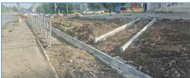
Укладка тротуаров на ул. Связистов
