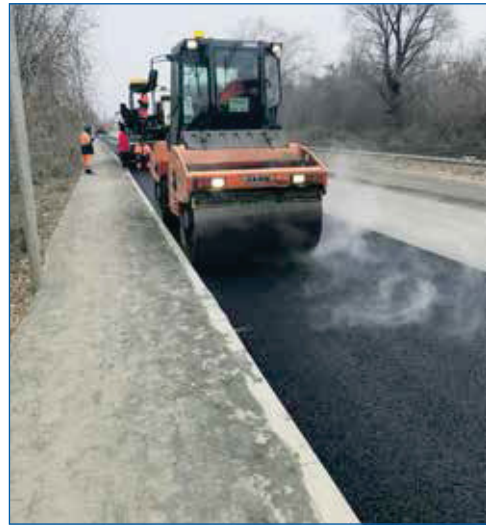
Ремонт дороги на улице Клубной
