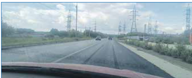
Асфальтирование проезжей части на ул. Дукача
