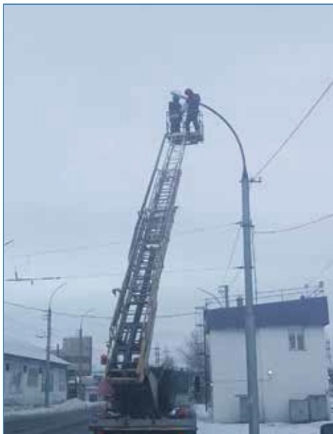
Замена уличных фонарей на улице Клубной
