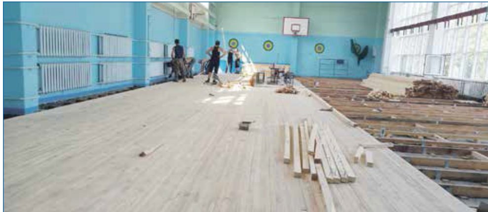
Замена пола в спортзале школы № 90
