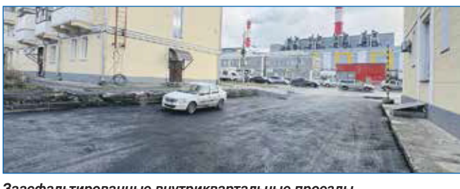
Заасфальтированные внутриквартальные проезды на ул. Станционной, 8 и ул. Станционной, 10
