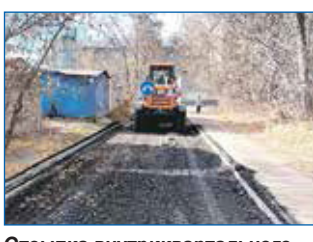
Отсыпка внутриквартального проезда между ул. Фасадной и ул. Забалуева
