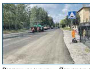
Ремонт дороги на ул. Пархоменко от ул. Колхидской до ул. Филатова
