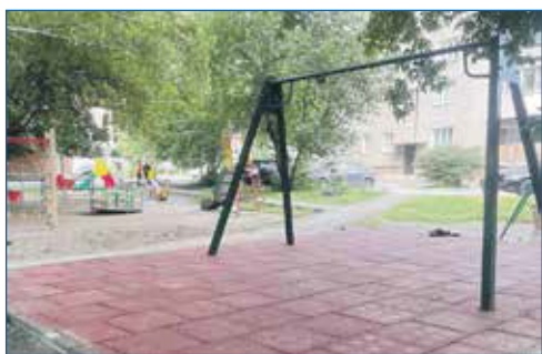
Выполняется установка уличных тренажеров и элементов детского городка с безопасным покрытием на ул. Вертковская, 39/1
