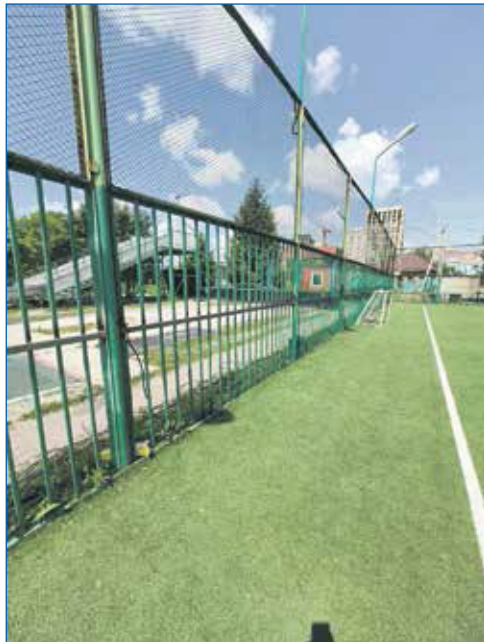
На «Спортивной поляне» восстанавливают и укрепляют ограждение
