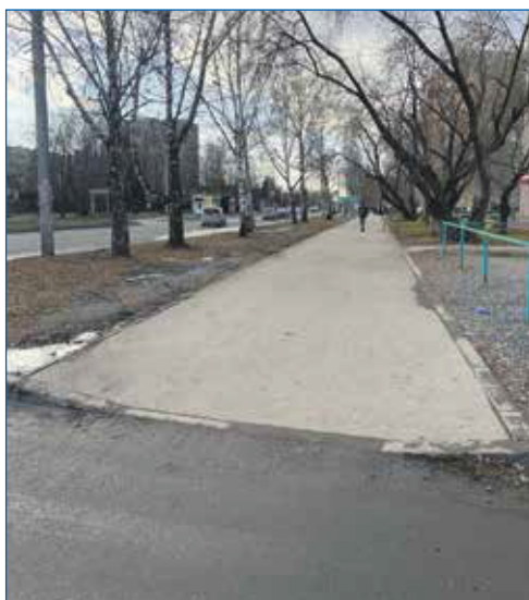
Капитальный ремонт пешеходного тротуара от дома по ул. Громова, 7, до дома по ул. Зорге, 145
