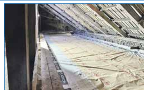
Ремонт крыши ДДК им. М. И. Калинина
