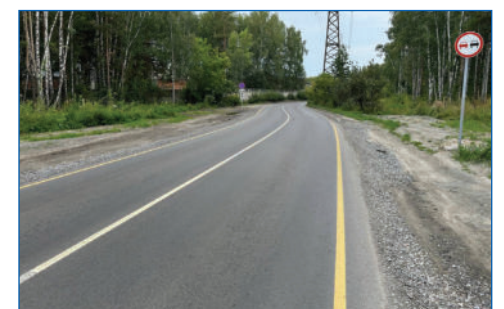
Капитальный ремонт ул. Иванова от НВВКУ в сторону в сторону трассы на Кольцово
