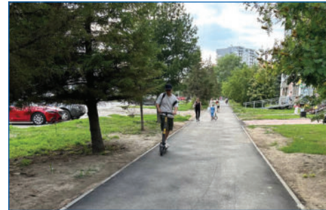
Ремонт тротуара по нечетной стороне ул. Демакова
