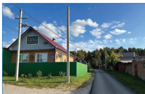
Замена опор ЛЭП и асфальтирование соединения улиц Иртышской и Рощинской
