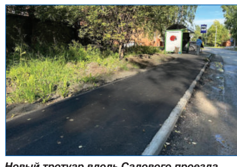
Новый тротуар вдоль Садового проезда в микрорайоне Благовещенка
